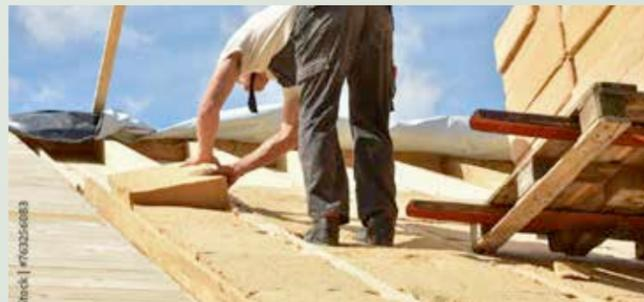
Ist das Dach noch gut gedeckt, spricht: die Dachdeckung und die entsprechenden Dachabdichtungen sind voll funktionsfähig, lässt es sich im Nachhinein auch von innen gut dämmen, am besten mit einer Kombination aus Zwischensparrendämmung und Untersparrendämmung.
